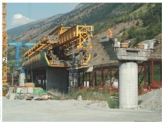
Der Übergang vom Kasten- zum Trogquerschnitt wird durch ein sukzessives Hinunterführen der oberen Kastenplatte zwischen den Stegen bewerkstelligt. Die Erstellung des Überbaus erfolgte für die meisten Felder mit einem obenliegenden Vorschubgerüst. Für die Vorspannung kam erstmalig an einem grösseren Objekt in der Schweiz Kategorie c (vollständig elektrisch isolierte Kabel) zur Anwendung.
