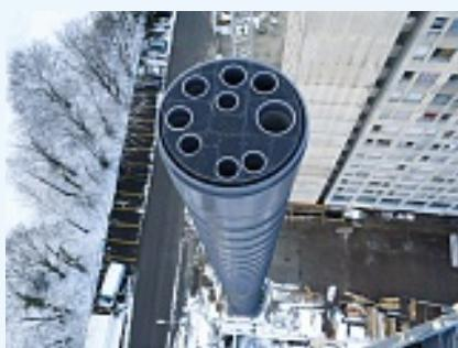
Der Aufbau der Tragkonstruktion, der Unterverkleidung und die schlussendliche Schieferverkleidung dauern vier Monate. Dafür wurden 160 000 Schrauben, 80 000 Schieferplatten und 160 Tonnen Material für die Kaminanlage verwendet.
