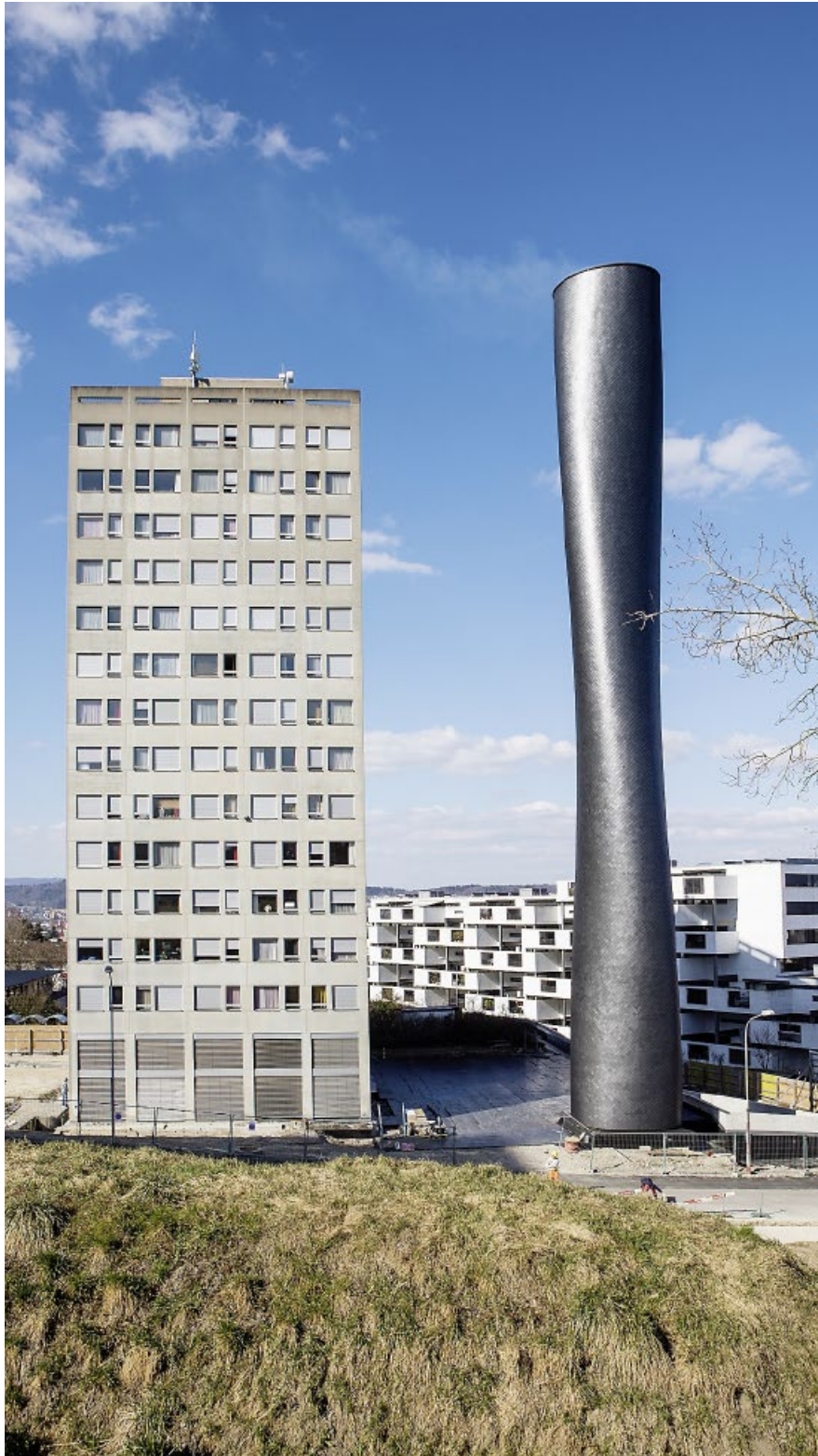
Der neue Kamin ist Teil einer hochmodernen Energieanlage. Foto: Giorgia Müller
