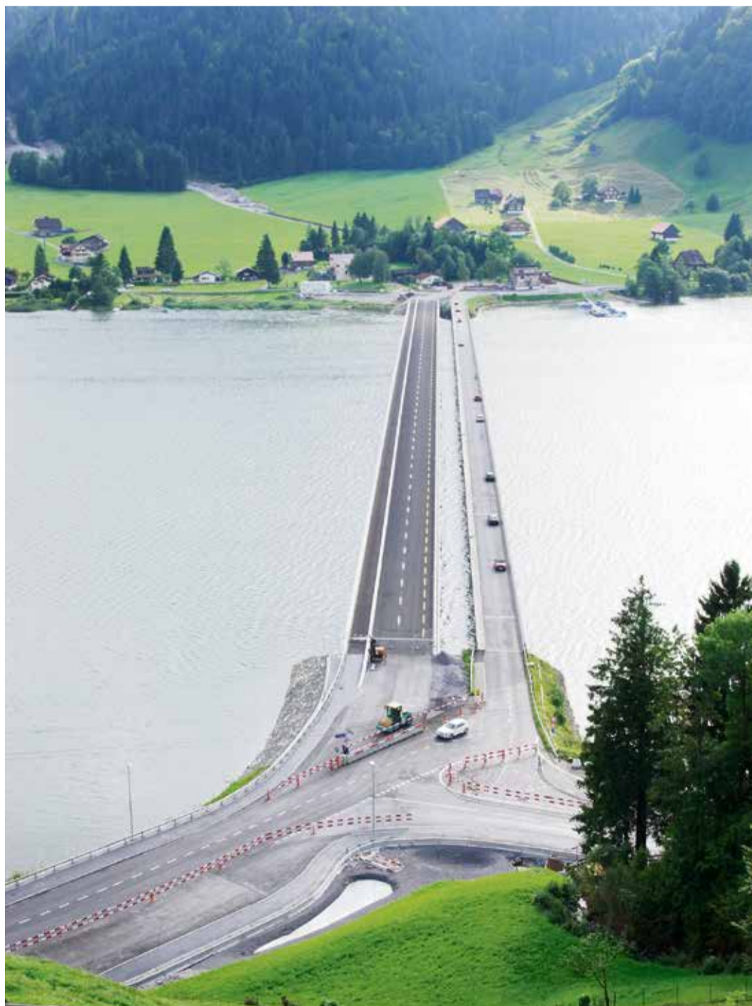
Aus der «Vogelperspektive» gut zu erkennen: Der neue Viadukt ist merklich breiter als der alte. Foto: Franz Kälin
