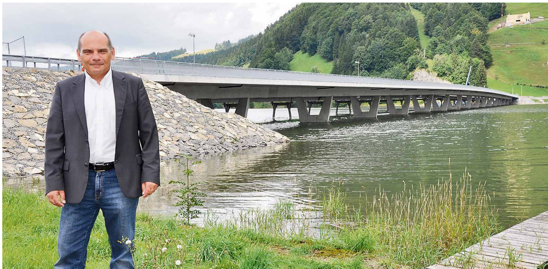
«Wie ein feines Band»: Bruno Kälin, der Abteilungsleiter für Kunstbauten, zum neuen Steinbach-Viadukt.
