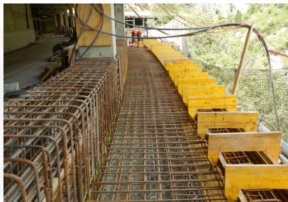
Bewehrung Randleitmauer und Kragplatte
