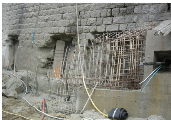
Verstärkungsriegel am Stützmauerfuss
