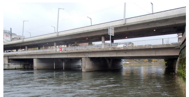
Ansicht Wipkingerbrücken (unten) und Hardbrücke (oben)
