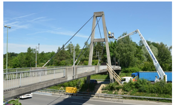
Ansicht Schrägkabelbrücke PÜF Oberwies
